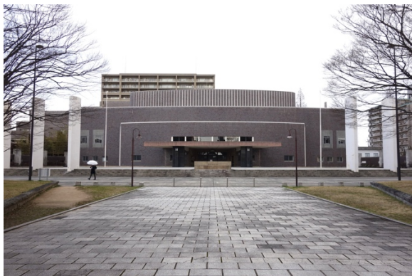
山口県・宇部市渡辺翁記念会館※ (1937 年竣工・重要文化財)
