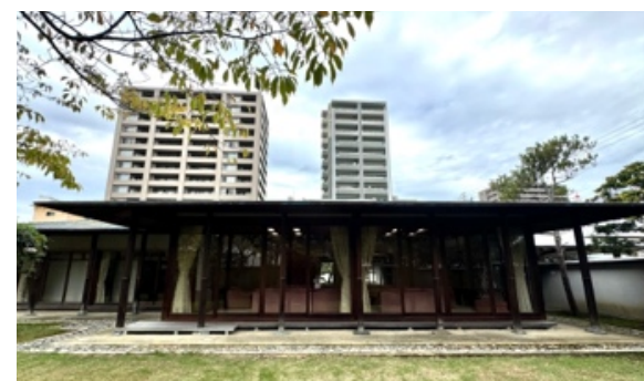
軒を長く張り出した公邸部分
